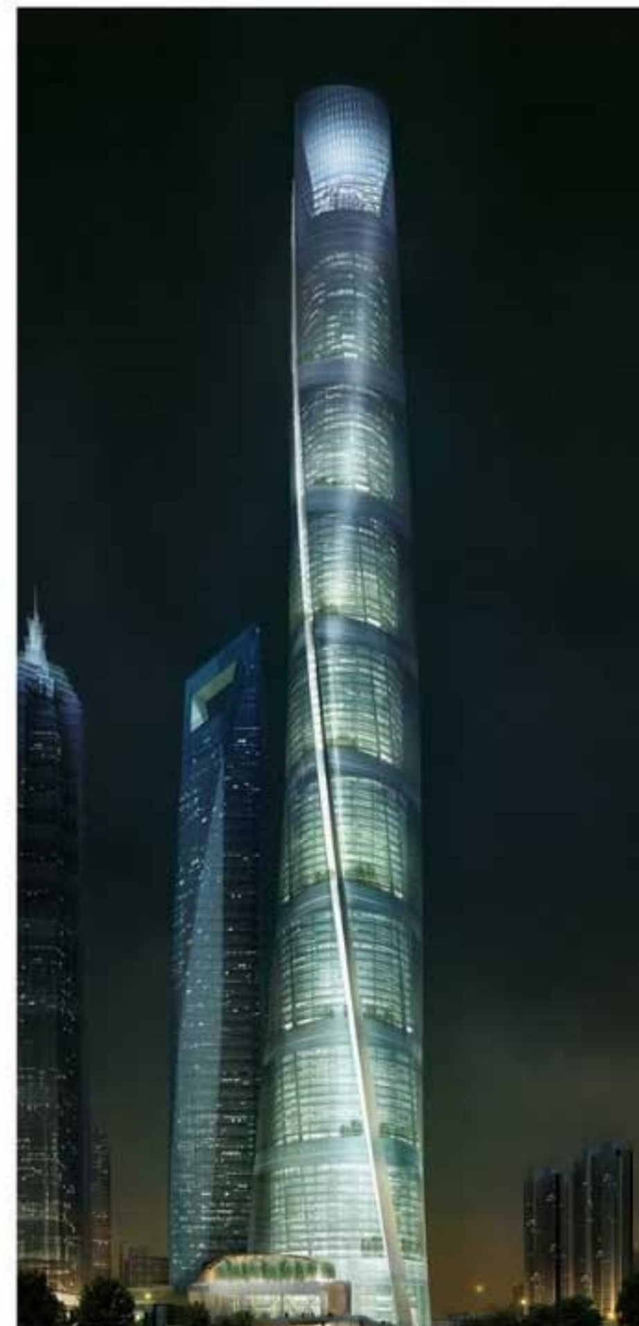
上海中心大厦（632米、124层，在建） Tower, under construction, height-632m, 124 floors.
