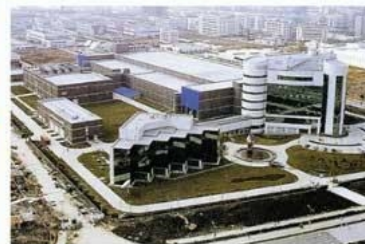
华虹NEC微电子厂 Shanghai Hua Hong NEC
