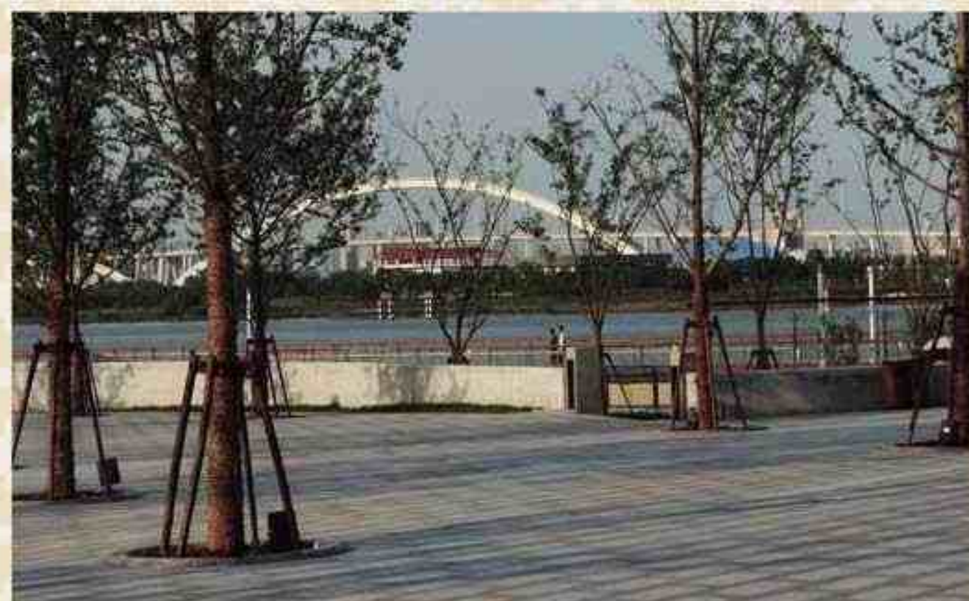
2.白莲泾泵闸工程
