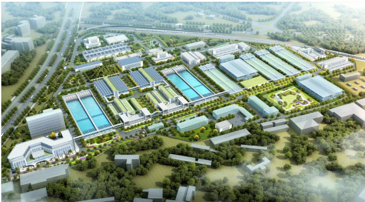
涵盖勘察测量、初步设计、施工图设计、监理、招标代理、造价咨询、项目管理等。项目包括改建30万吨/d常规处理、新建90万吨/d深度处理及污泥处理的深度处理水厂。
