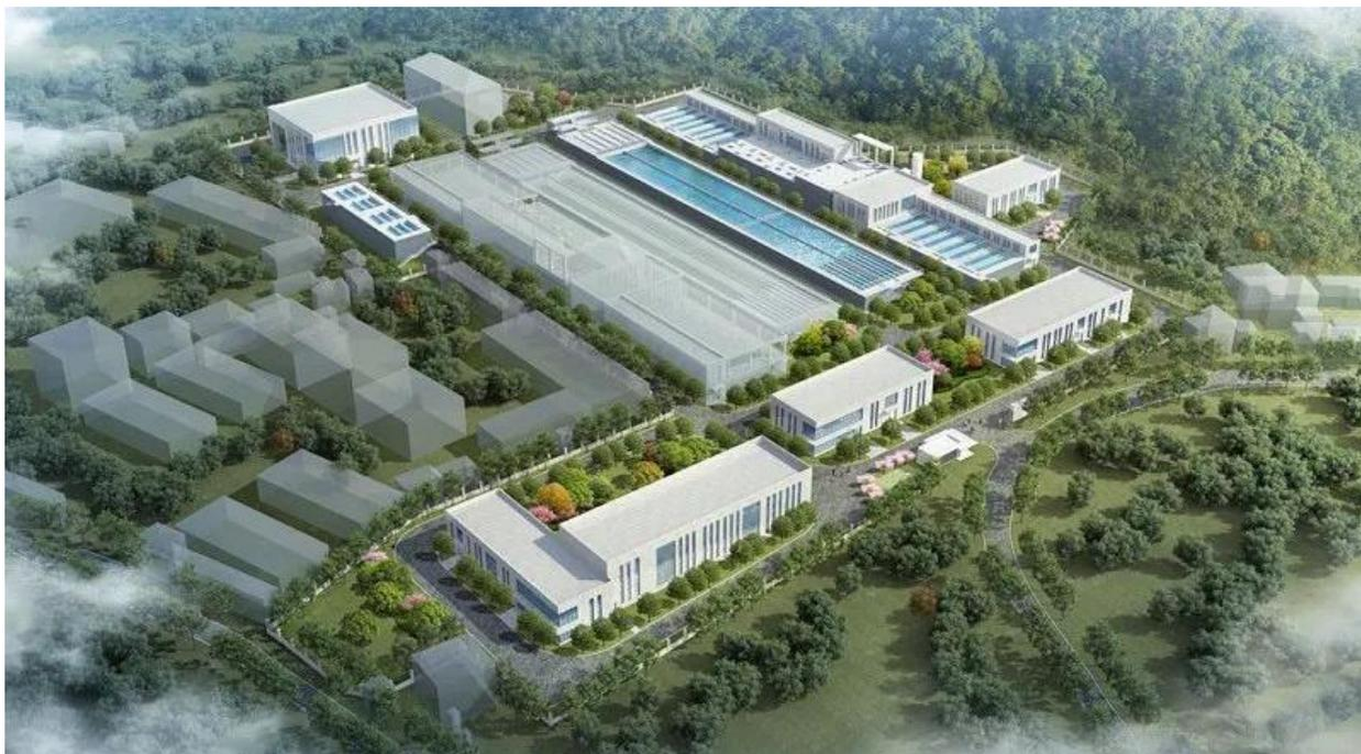
项目采用“全流程、多手段”的强化常规处理工艺+深度处理+后置滤池的工艺流程，应对可能出现的原水风险，并打造无人化、智能化系统段，全系统、多维度构建智慧管控平台，将数字化与水务业务深度融合，打通设计、施工、运维全过程数字化应用流程，打造智慧化高品质水厂。
