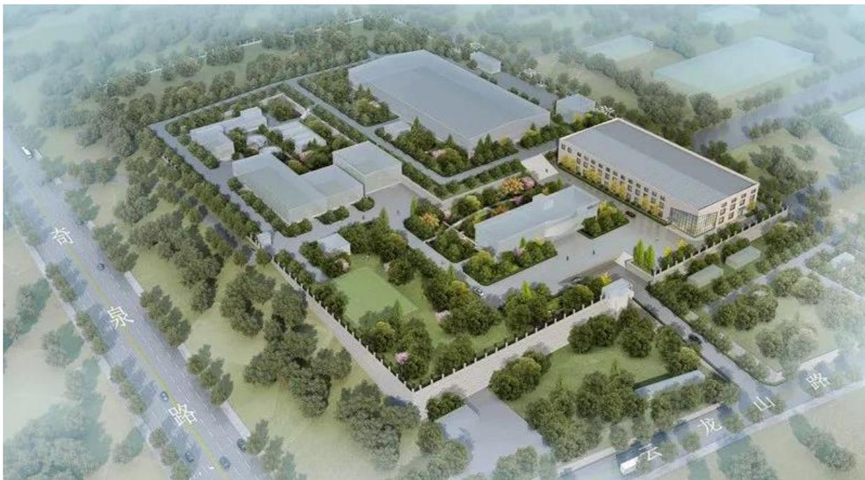
水厂深度处理建设规模16万m<sup>3</sup>/d，针对原水硝酸盐超标的问题，采用“超滤+反渗透”的深度处理工艺，不仅保障城市供水安全，也为以后的高品质供水打下良好的基础。
