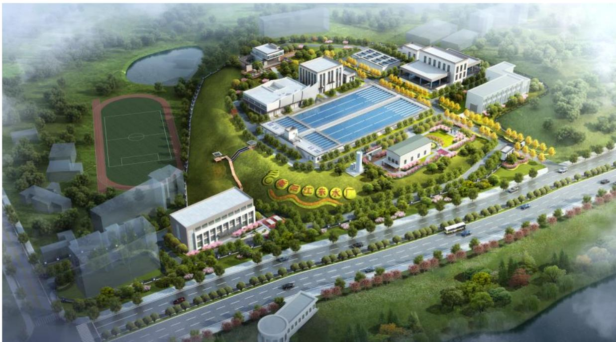
拆除于1973年建立的老旧净水系统，原址新建10万 $m^3$ 常规处理+深度处理+污泥处理。项目结合当地水质特点，采用精简型全流程工艺，缩短常规流程工序的同时满足深度处理需求，并采用交叉式施工方案，在改造期间仍确保5万 $m^3/d$ 安全供水。
