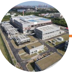
石洞口污水处理厂二期
