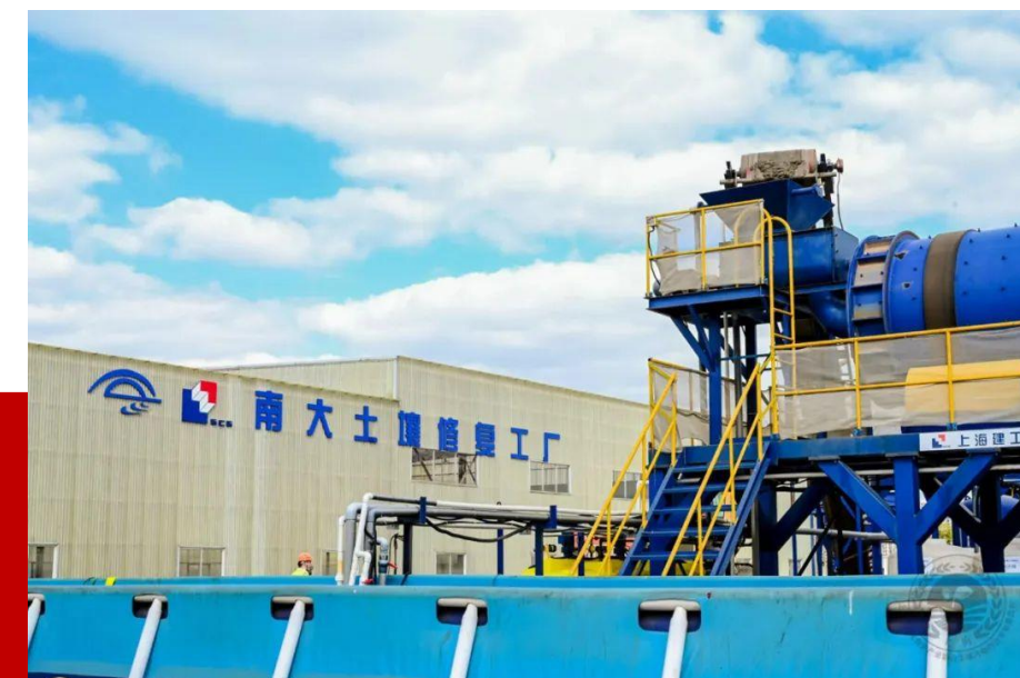
上海建工宝山南大土壤修复工厂
