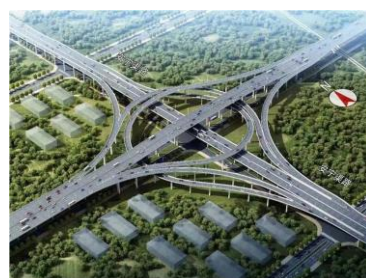
东进场高架道路
