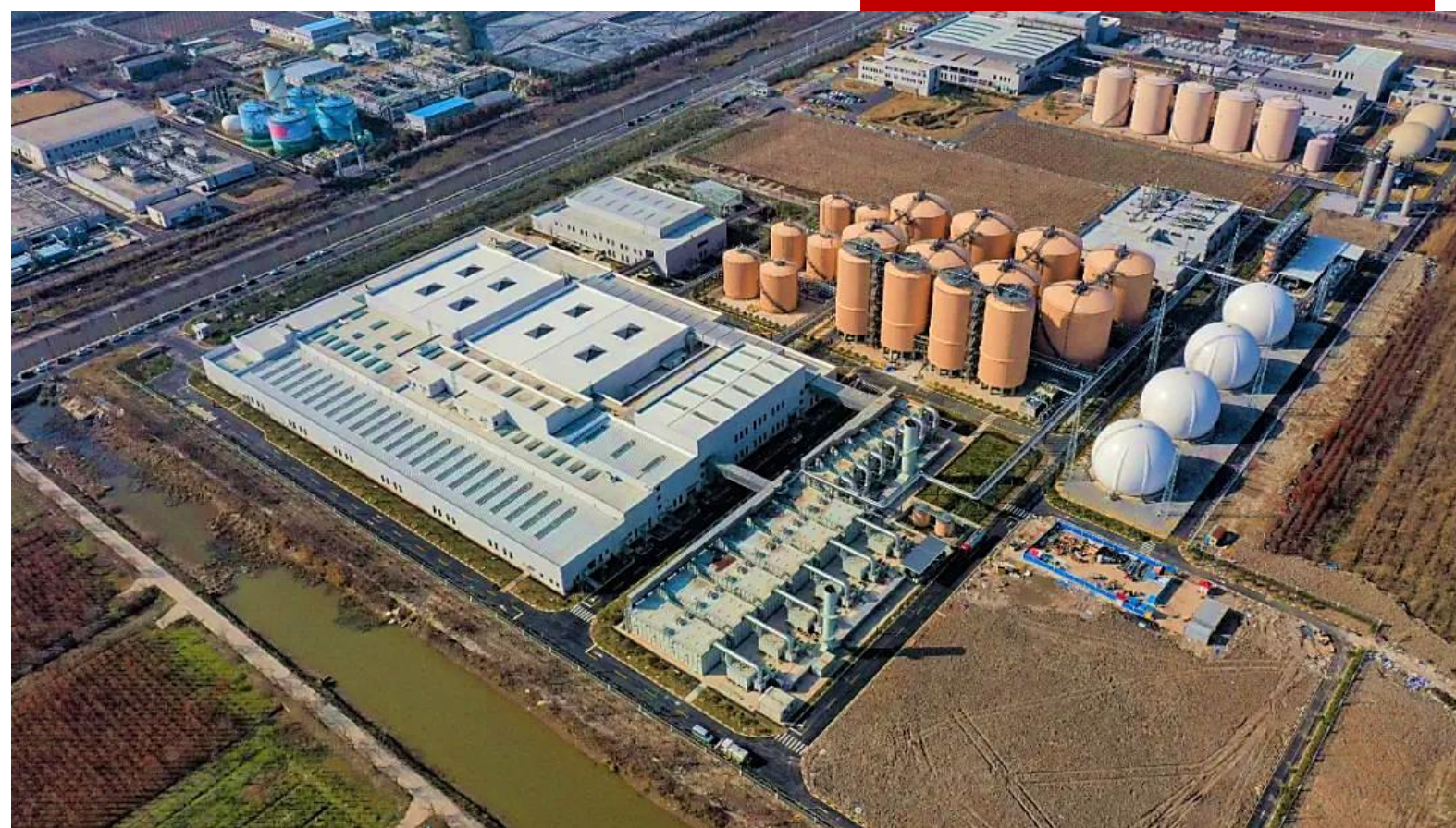
上海生物能源再利用项目（二期）
