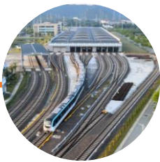
无锡地铁3号线一期工程
