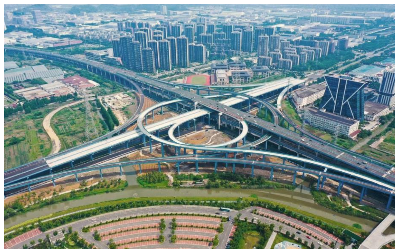
宁波西洪大桥及主线高架
