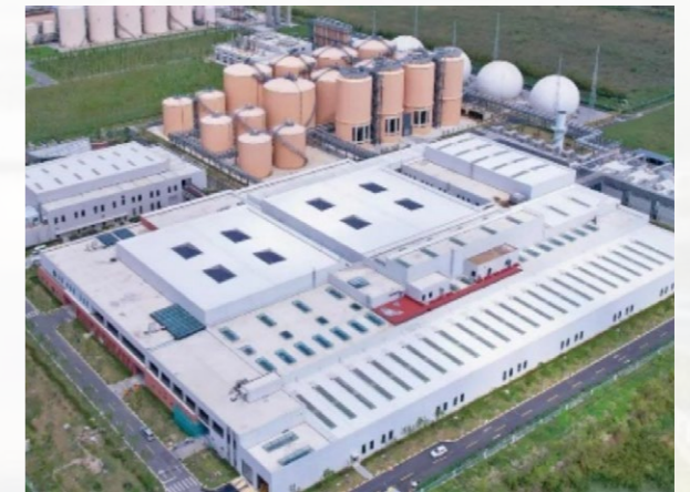
老港生物能源再利用二期
