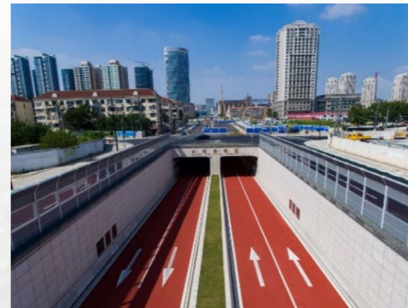
江浦路越江隧道新建工程
