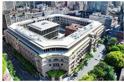
黄浦区 160 街坊保护性综合改造工程 (老市府大楼)
