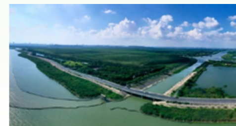
巢湖生态清淤及湿地修复一期工程
