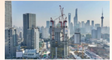
超高层建筑的质量极限 - 上海“浦西第一高”北外滩中心
