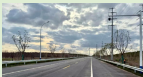
老港基地使用再生建材打造绿色生态园区
