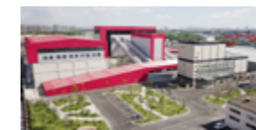
废水零排放搅拌站
