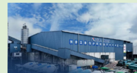
工程土方资源化利用
