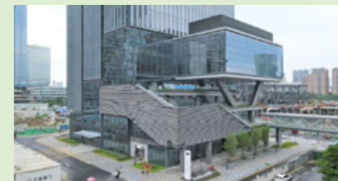
广州国际航运大厦 BIM 优化节材
