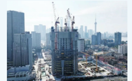
“未来浦西第一高楼”——北外滩中心建设突破 100 米
