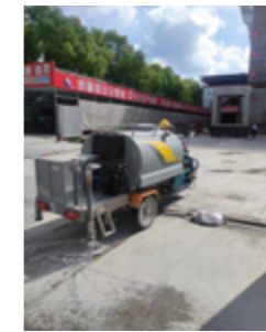
施工基坑水回用
